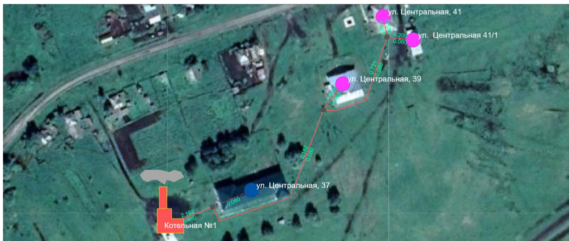
Рисунок 2. Зона действия котельной №1
